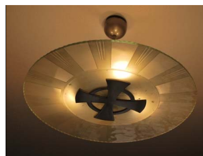
Originalarmatur i vapenhuset.
