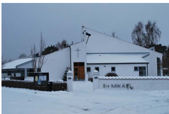
Fasad mot söder med huvudentré.
