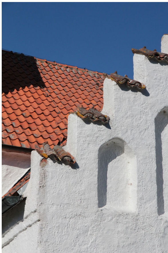
Vapenhusets trappstegsgavel har bevarat sin avtäckning med munk och nunnetegel.
