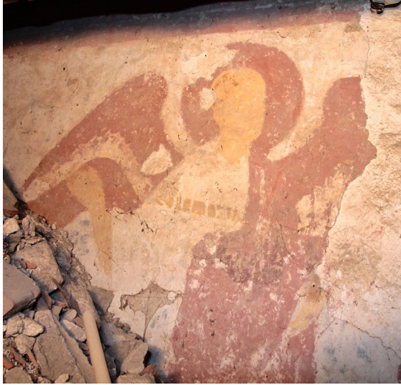
Romansk målning ovan valv på södra sidan på triumfväggen (väggen mellan långhus och kor) föreställande en ängel.
